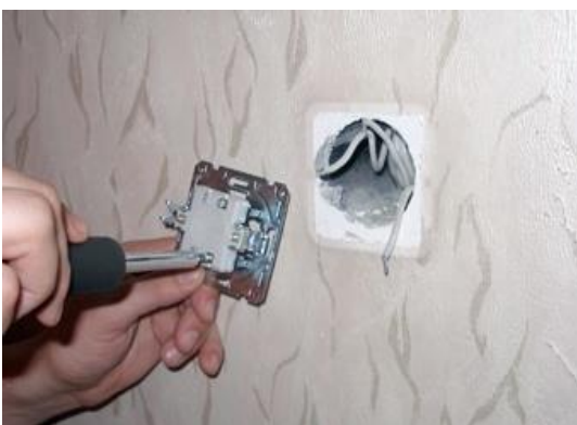
Встановлення вимикачів
