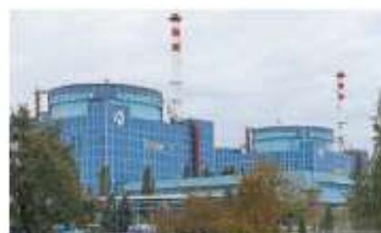
Рис. 42.9. Хмельницька АЕС: 2 атомні енергоблоки потужністю 1000 МВт кожен
