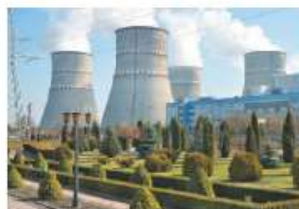
Рис. 42.7. Рівненська АЕС: 4 атомні енергоблоки загальною потужністю 2835 МВт
